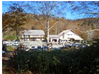
⑧ 鳩待峠の休憩所・バス停・駐車場
