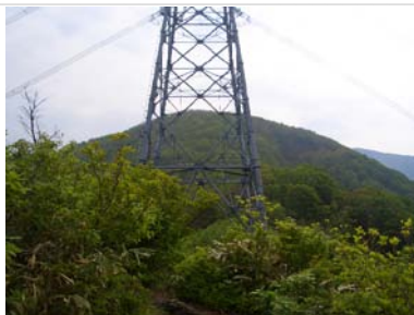
② 巨大鉄塔（送電）下広場
