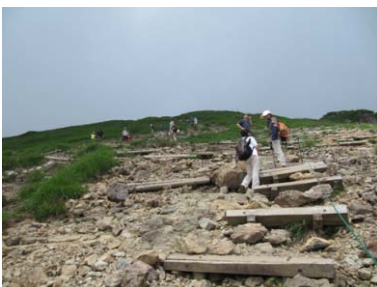
③ 谷川岳・肩の下の階段
